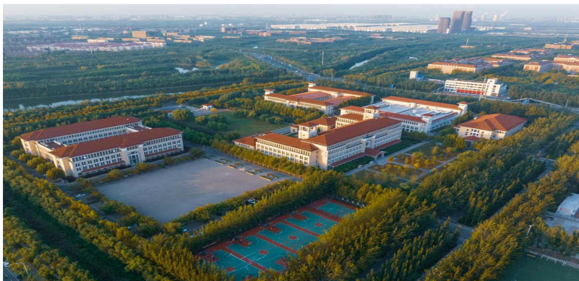
图 63 信息产业综合实训中心及配套设施工程落成
